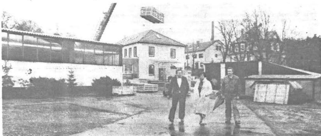
Mitten auf der Trasse der L 418 stehen die Mitglieder der Firmenleitung von Schmersal – auf ihrem Fabrikhof. Foto: Rainer Haldenwang
