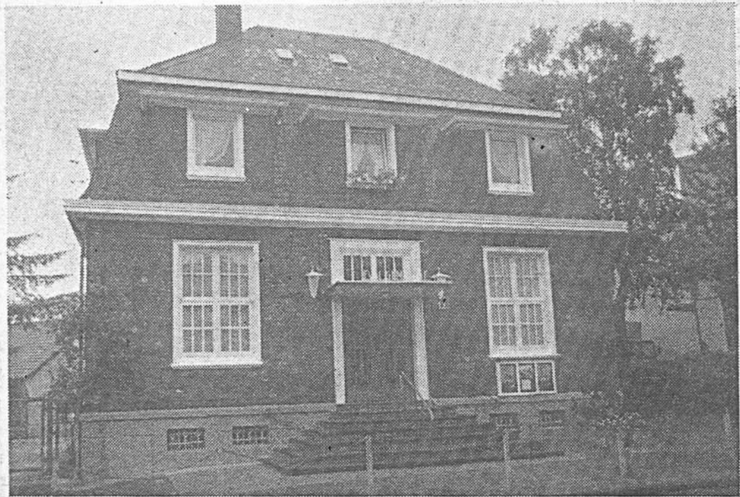
Zu einem wahren Schmuckkästchen ist das Gemeindehaus Küllenhahn, das für Gottesdienste genutzt wird, nach seiner Renovierung geworden.
